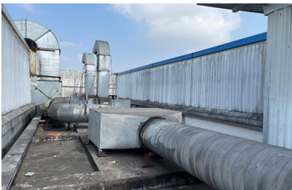
Hình 9. Hình ảnh hệ thống xử lý khí thải đã lắp đặt tại xưởng C4 và C5
